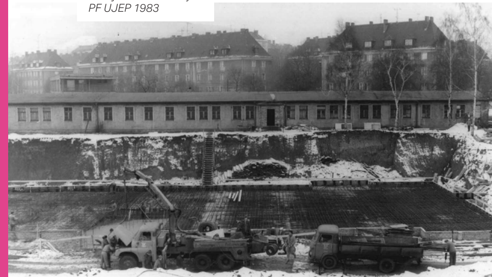
Zahájení nové stavby PF UJEP 1983
